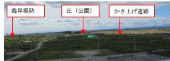
荒浜小学校屋上より西側を望む
