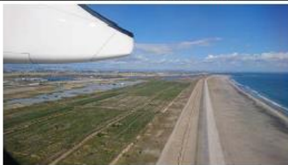
粘り強い堤防として整備された仙台湾南部海岸堤防
