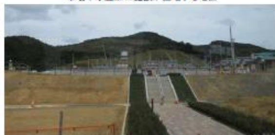
高台に造成が進む住宅団地(宮ヶ崎地区)
