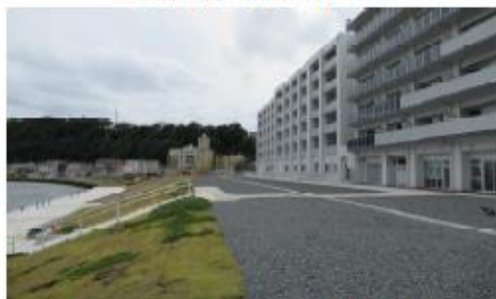
かわまちづくりによる旧北上川堤防の整備(中央地区)
