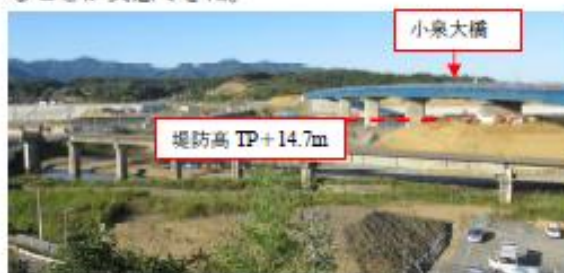
気仙沼市津谷川河口部の復旧状況
