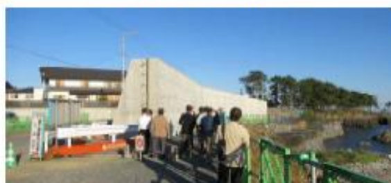
気仙沼市岩井崎海岸の復旧状況
