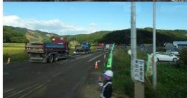
写真-10 工事用道路と土砂運搬のダンプトラック
