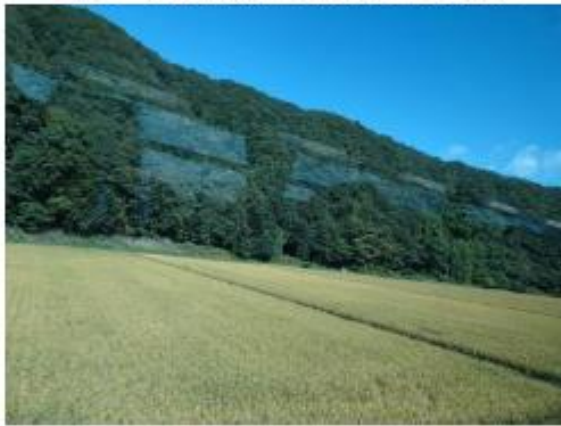
写真-6 崩壊箇所横の急傾斜区間（車窓より）
