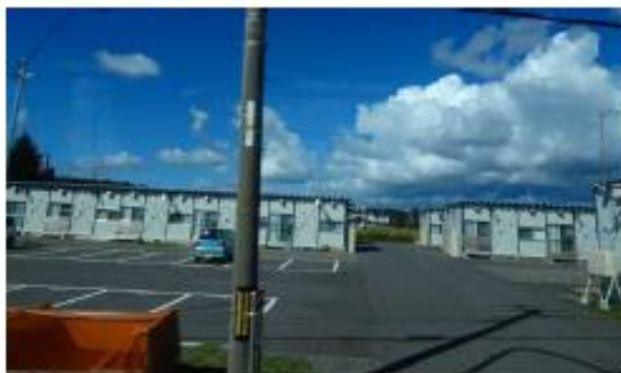
写真-4 仮設住宅の設置状況
