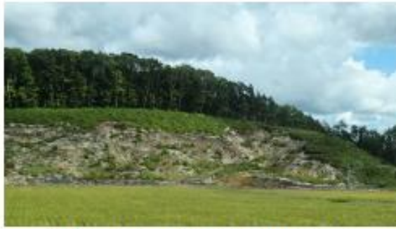
写真-2 車中にて小規模な被災斜面を望む
