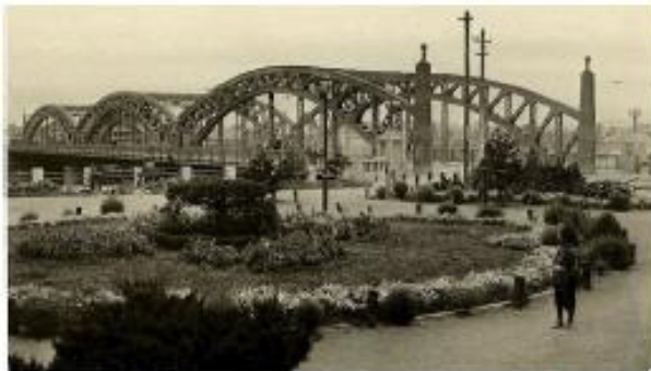
写真-35 廣井が手掛けた豊平橋（大正13年供用）
