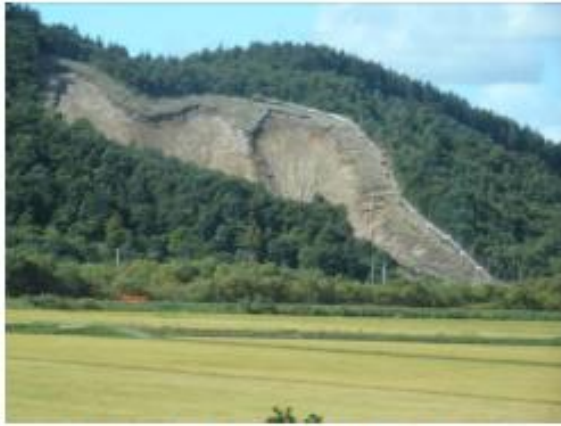
写真-5 深層崩壊発生場所の現状（車窓より）
