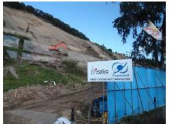
写真-9 斜面用バックホウ（中央部）
