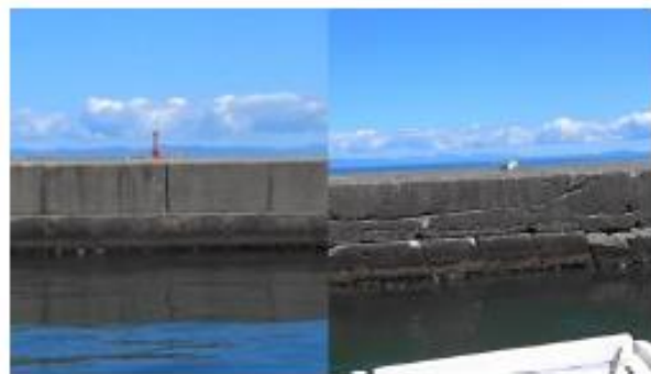
写真-23 傾斜ブロック（左：北防波堤、右：南防波堤）
