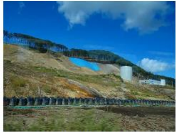
写真-8 新浄水場の現状（車窓より）
